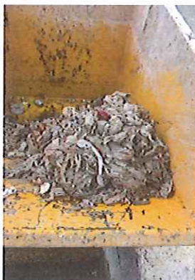
Refus de dégrillage en entrée de station d'épuration
